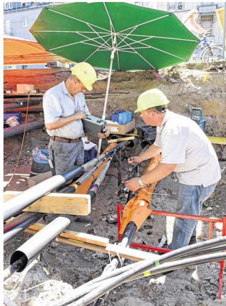
Benno Suegis und Michael de Bruin (v. l.) von der MVV Energie AG arbeiteten gestern in Neckarau mit Hochdruck an der Reparatur der schadhaften Leitung. BILD: TRÖSTER
