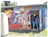
Ein Trafohaushaus in der Gartenstadt, in dem es brannte. BILD: TRÖSTER
